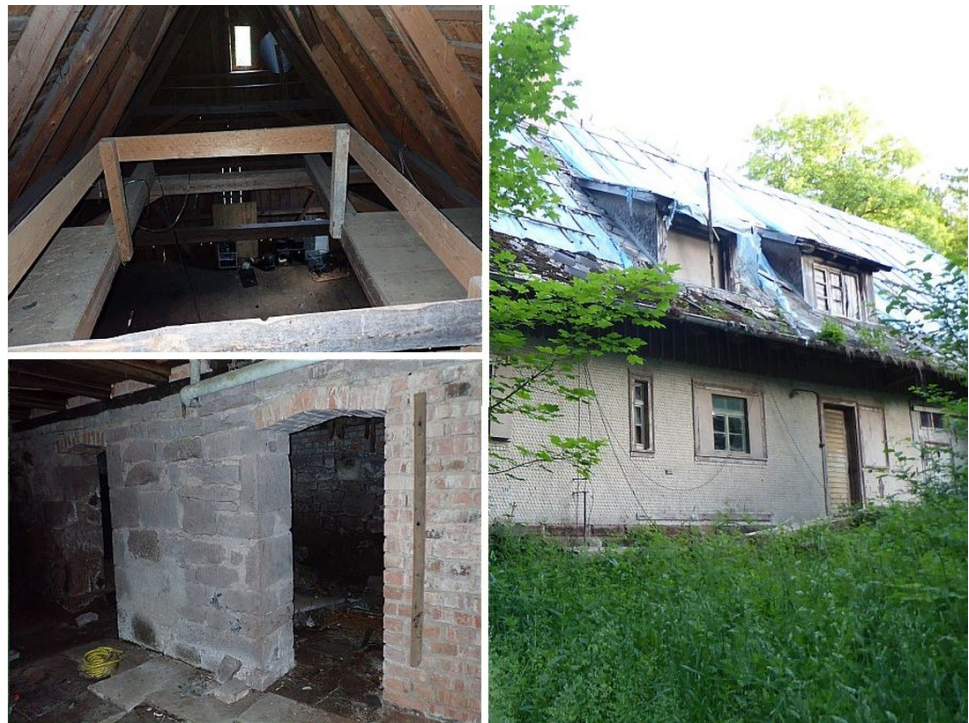
Abb. 15: Dachboden, Keller und Außenfassade des Ökonomiegebäude.
