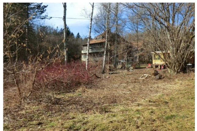
Abb. 6 Zerfallendes Gebäude des ehemaligen Kindersanatoriums
